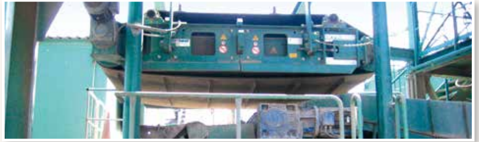
Szeroki na 2 metry podwieszany separator elektromagnetyczny do przetwarzania odpadów budowlanych i rozbiórkowych
