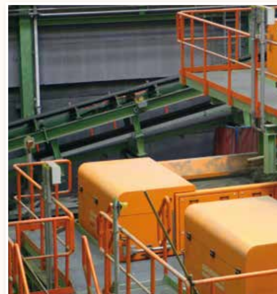
Trzy separatory wirowo-prądowe, typ NF1500 używane w procesie przetwarzania żużla w spalarni odpadów
